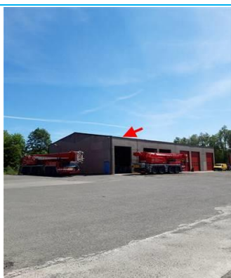
Matériaux : ZPSO-003 Prélèvement : Description : Plaques en fibres-ciment (y compris plaques « sous tuiles ») Localisation : Bâtiment 15.2 - Hangar Résultat : Présence d'amiante
