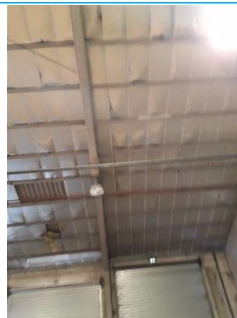
Matériaux : P002 Prélèvement : P002 Description : Isolant en sous toiture Localisation : Rez de chaussée bâtiment 15 - Hall 1 Résultat : Absence d'amiante
