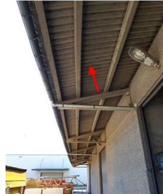
Matériaux : ZPSO-002 Prélèvement : Description : Plaques en fibres-ciment (y compris plaques « sous tuiles ») Localisation : Rez de chaussée bâtiment 15 - Auvents Résultat : Présence d'amiante
